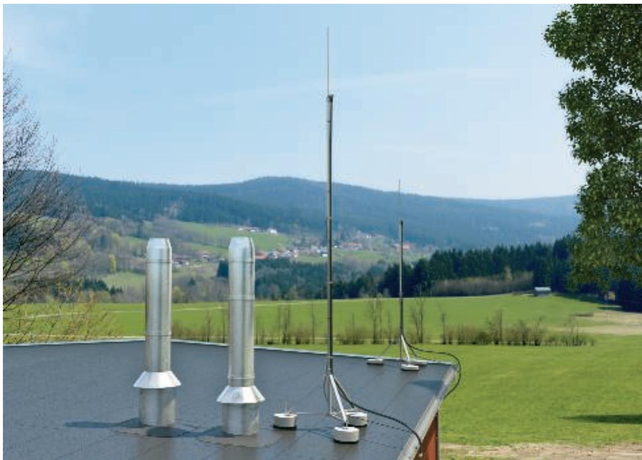
При монтаже на кровле сложных строительных сооружений часто бывает невозможно соблюсти разделительный интервал между молниеприемными и электрическими устройствами с помощью стандартных токоотводов. В таких случаях рекомендуется использовать системы изолированной молниезащиты, например, провод OBO isCon®.
