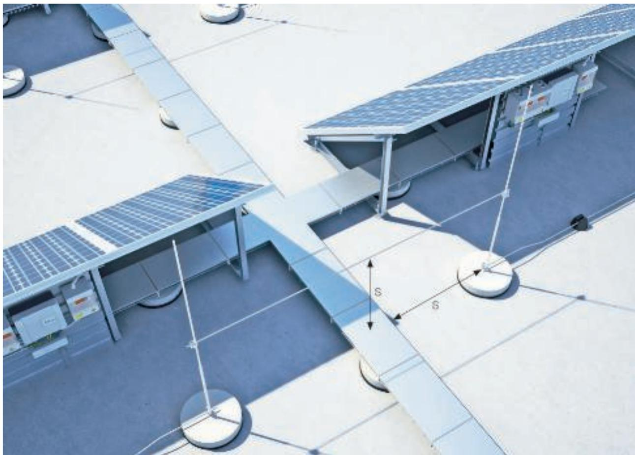
Рисунок 1: разделительный интервал ( $s$ ) между системой молниезащиты и кабеленесущей системой
