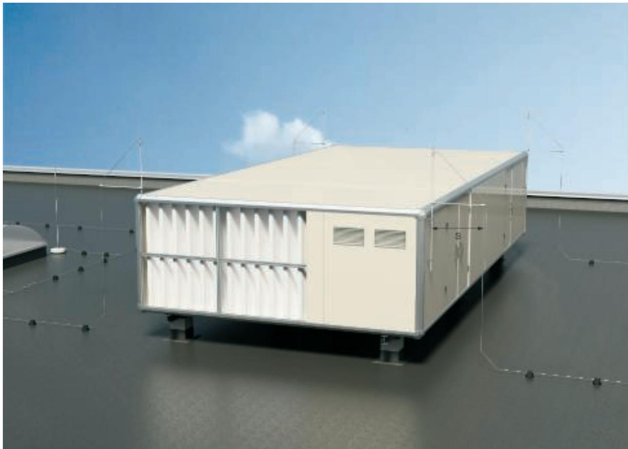
Изолированные молниеприемные устройства с разделительным интервалом (s)
