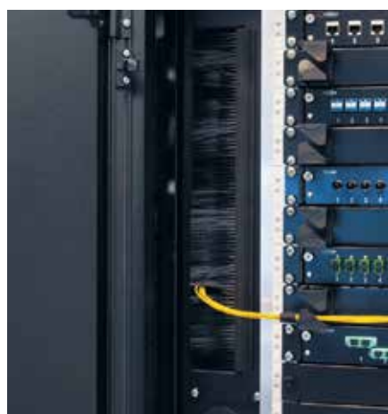
Щеточное уплотнение кабельного ввода
