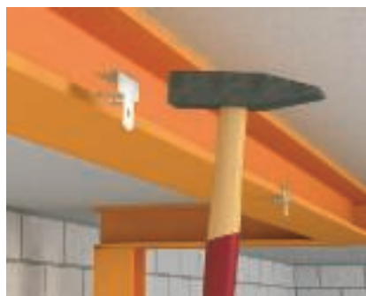
Вбивание балочных зажимов Балочные зажимы крепятся на фланец и забиваются молотком.
