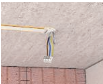
Применение линейных клеммных зажимов Концы жил у разъемов светильников можно обезопасить с помощью линейных клемм для светильников.
