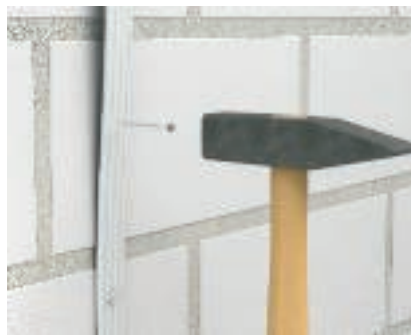
Гвоздь Siko Гвоздь Siko вставляется в промежутки между перемычками плоского провода.
