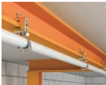
Монтаж балочного зажима Монтаж винтовых балочных зажимов параллельно фланцу.
