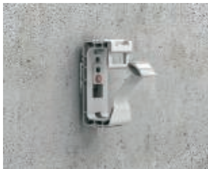
Готовый монтаж, групповое крепление-захват Защелкивающееся, групповое крепление-захват закрепленное на стене
