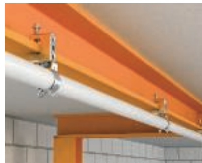
Монтаж балочного зажима Монтаж балочных зажимов и монтажной трубы перпендикулярно балке.
