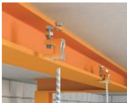
Крепление балочных зажимов Балочные зажимы крепятся к балке.
