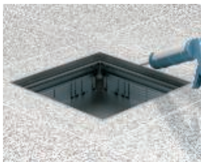
Укладка напольного покрытия вокруг кассетной рамки RK/RKF Уложить напольное покрытие вокруг кассетной рамки. Оставшийся зазор между напольным покрытием и кассетной рамкой уплотнить с помощью соответствующего материала.
