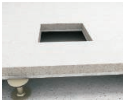
Подготовка к монтажу Пространство для монтажа кассетной рамки должно быть чистым.
