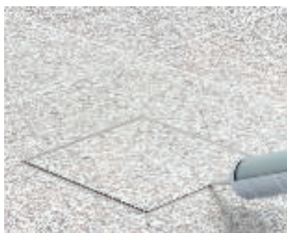
Укладка фрагмента напольного покрытия в кассетной рамке RKN Вложить фрагмент напольного покрытия в выемку в кассетной рамке и приклеить. Оставшийся зазор между напольным покрытием и кассетной рамкой уплотнить с помощью соответствующего материала.
