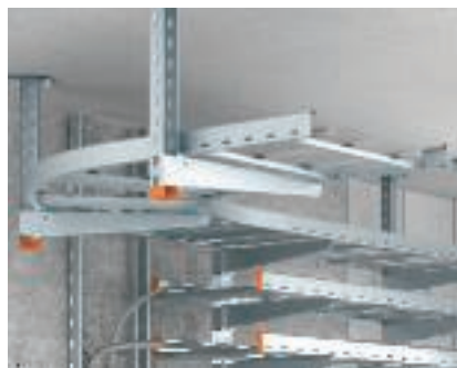
Готовый монтаж Установленный кабельный лоток лестничного типа.
